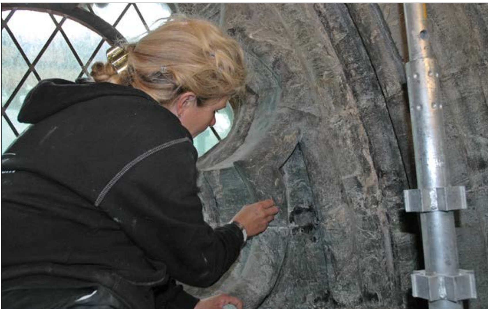
Steinkonservering innvendig på østsiden av søndre tårn i søndre sakristi, Stavanger Domkirke, i 2011. Konservator Ann Meeks renser kleberstein fra middelalder for sot og smuss. Fra Stavanger sentrum, Stavanger k., 2012. Foto: Jos Otten, Arkeologisk museum, Universitetet i Stavanger ©.
