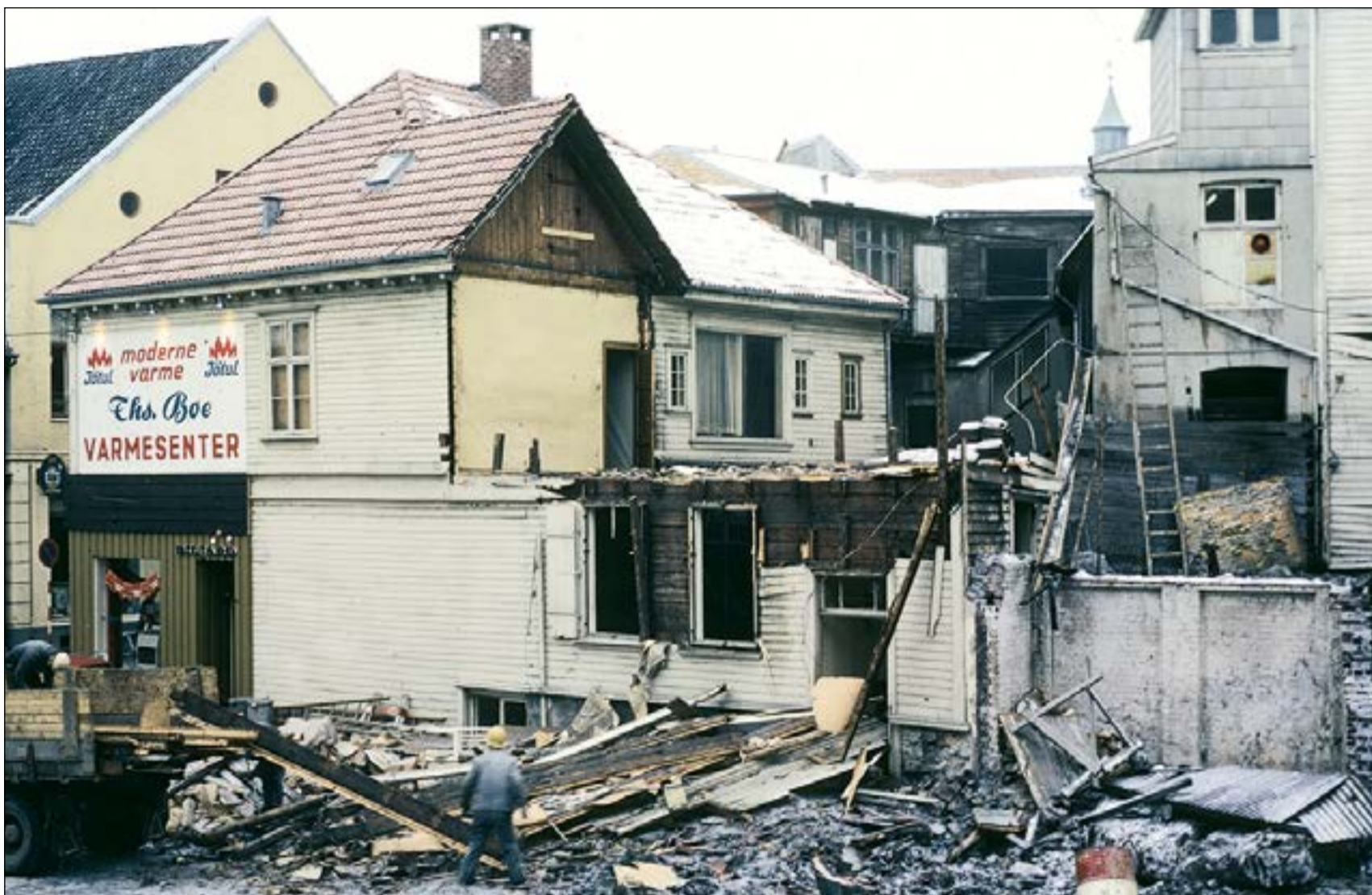
Nedrivning av trehus og klargjøring av tomt før undersøkelse av middelalderbygrunn i Stavanger sentrum i 1968. Fra Skagen 3, Stavanger k. Foto: Arkeologisk museum, Universitetet i Stavanger ©.
