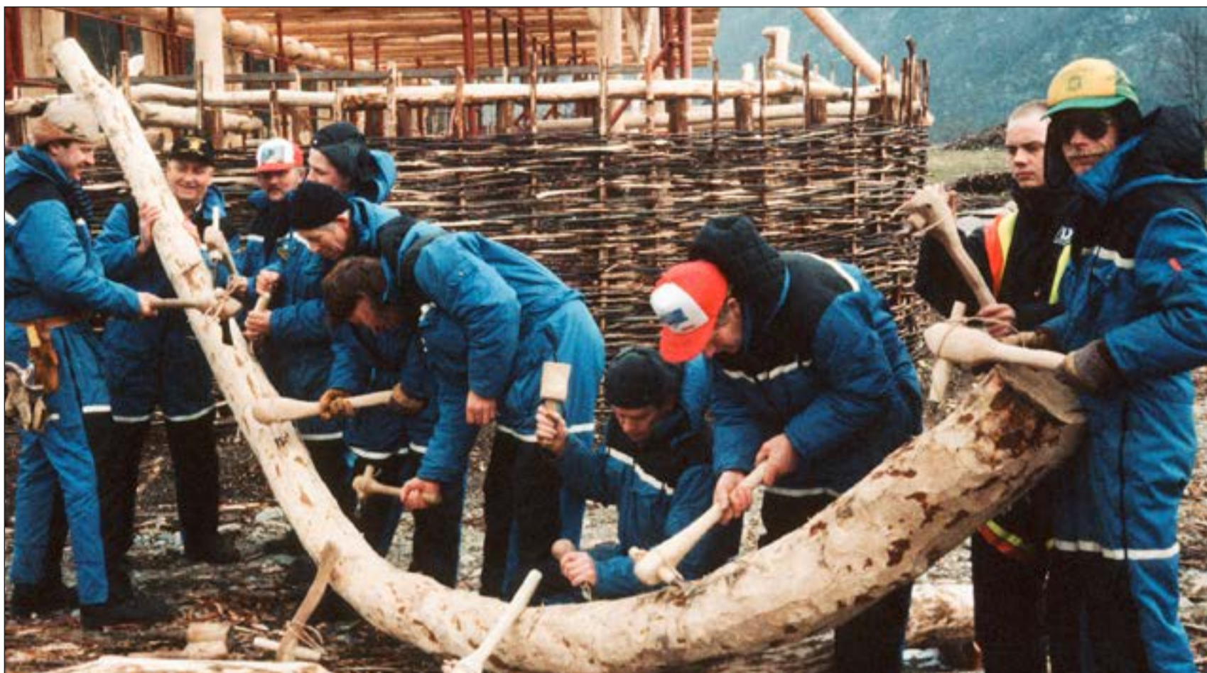
Til bronsealderhuset ble det brukt naturvokste emner som ble hentet ute i skogen. Foto: Sverre Bakkevig.
