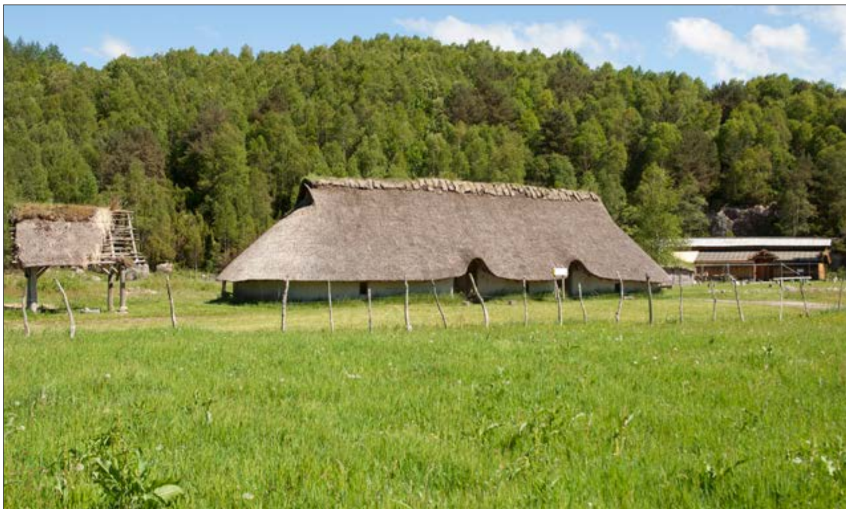
Stråtak på bronsealderhuset. Foto: Åge Pedersen.
