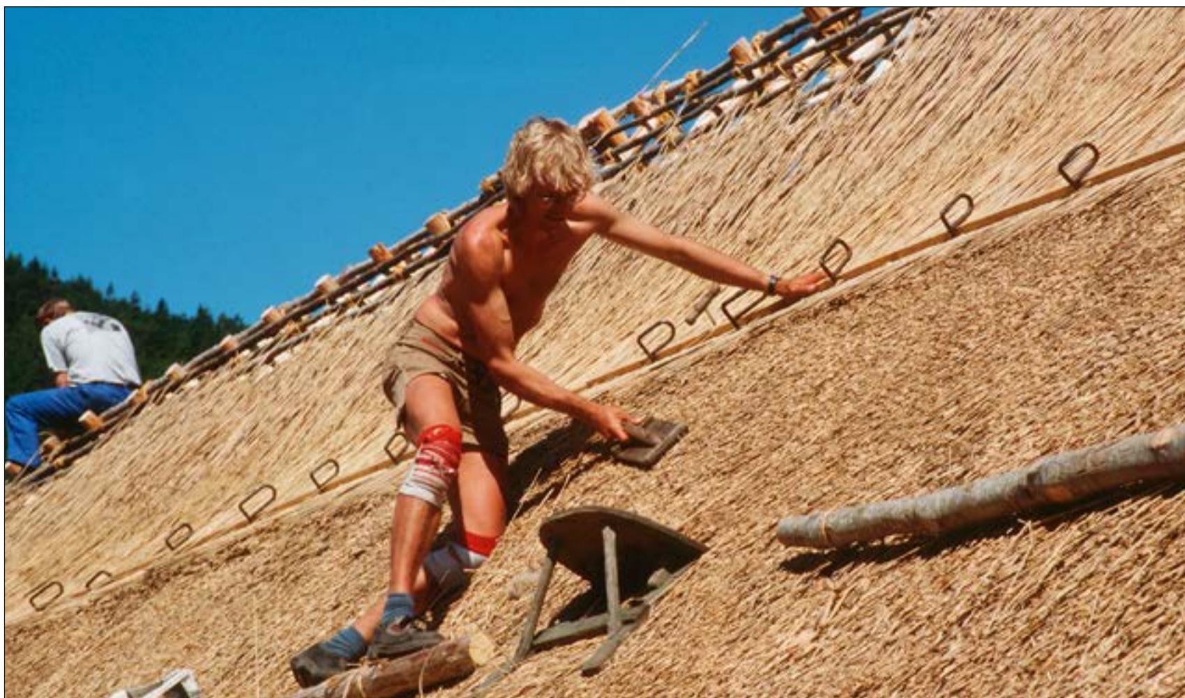
Et stråtak isolerer nesten like godt som moderne steinull. Bildet er fra legging av stråtak på bronsealderhuset i Fortidslandsbyen Landa på Forsandmoen. Foto: Åge Pedersen.
