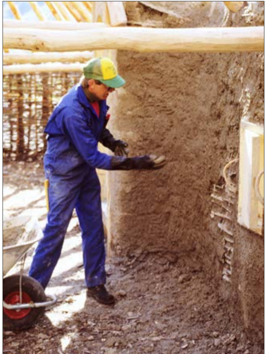
Blandingens klaskes på vegg slik at den fyller rommet mellom de doble flettverksveggene. Foto: Åge Pedersen.
