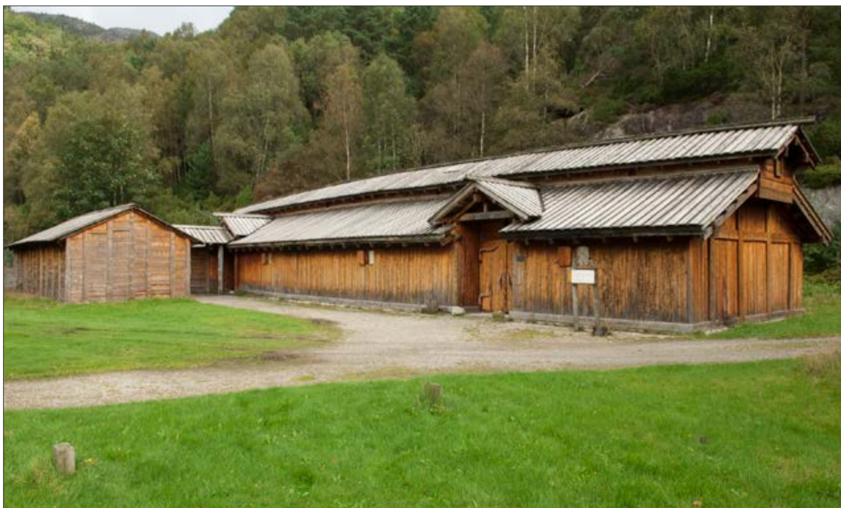
Planketak på Gildehallen. Foto: Terje Tveit.
