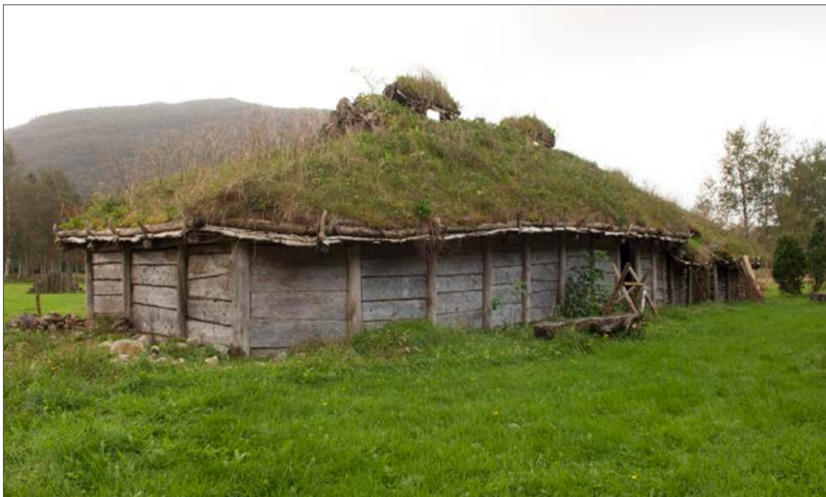
Torvtak på smiebygningen. Foto: Terje Tveit.
