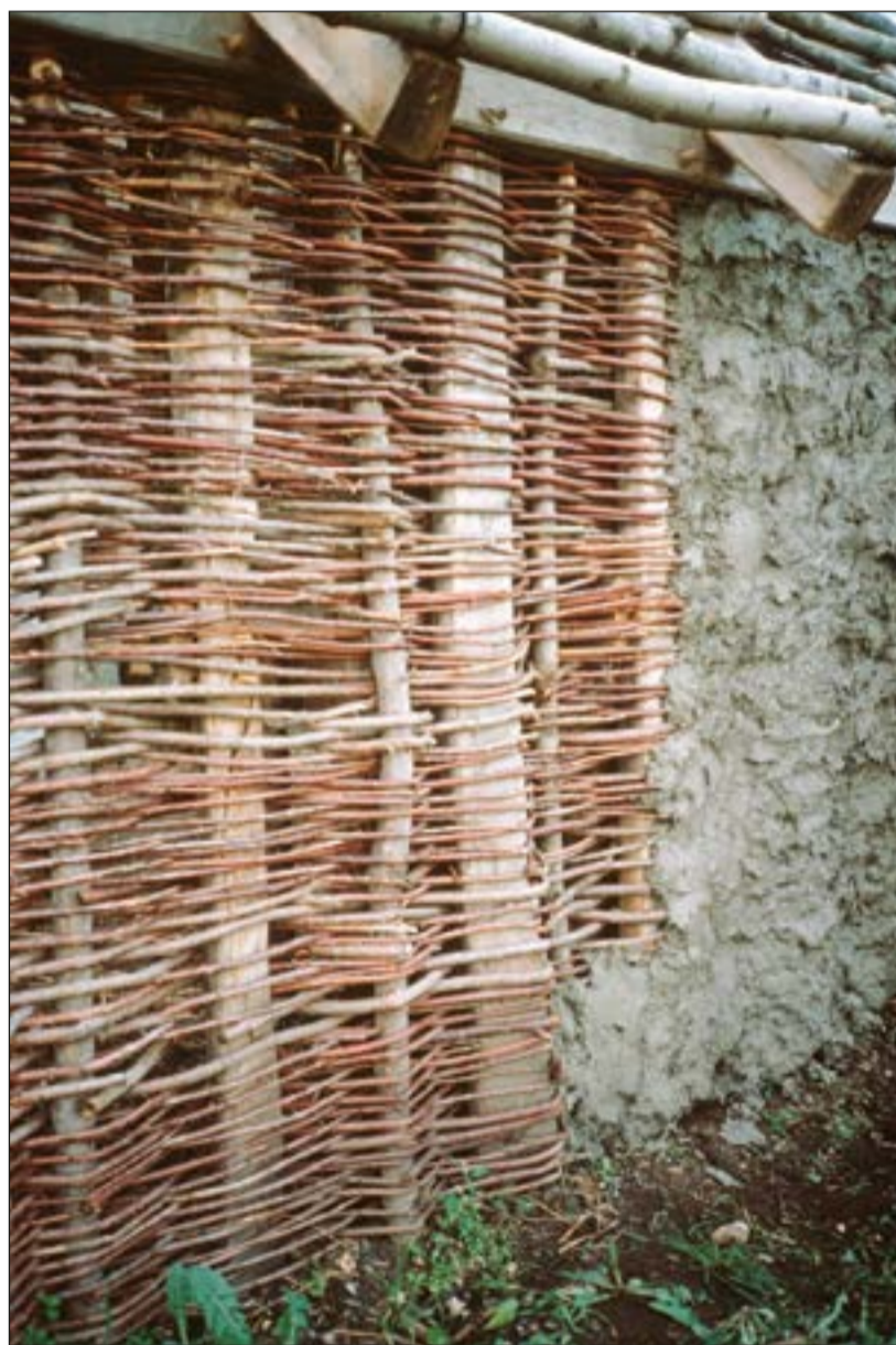
Flettverksveggen i bronsealderhuset, før den ble skjult av leirblanding. Foto: Trond Løken.
