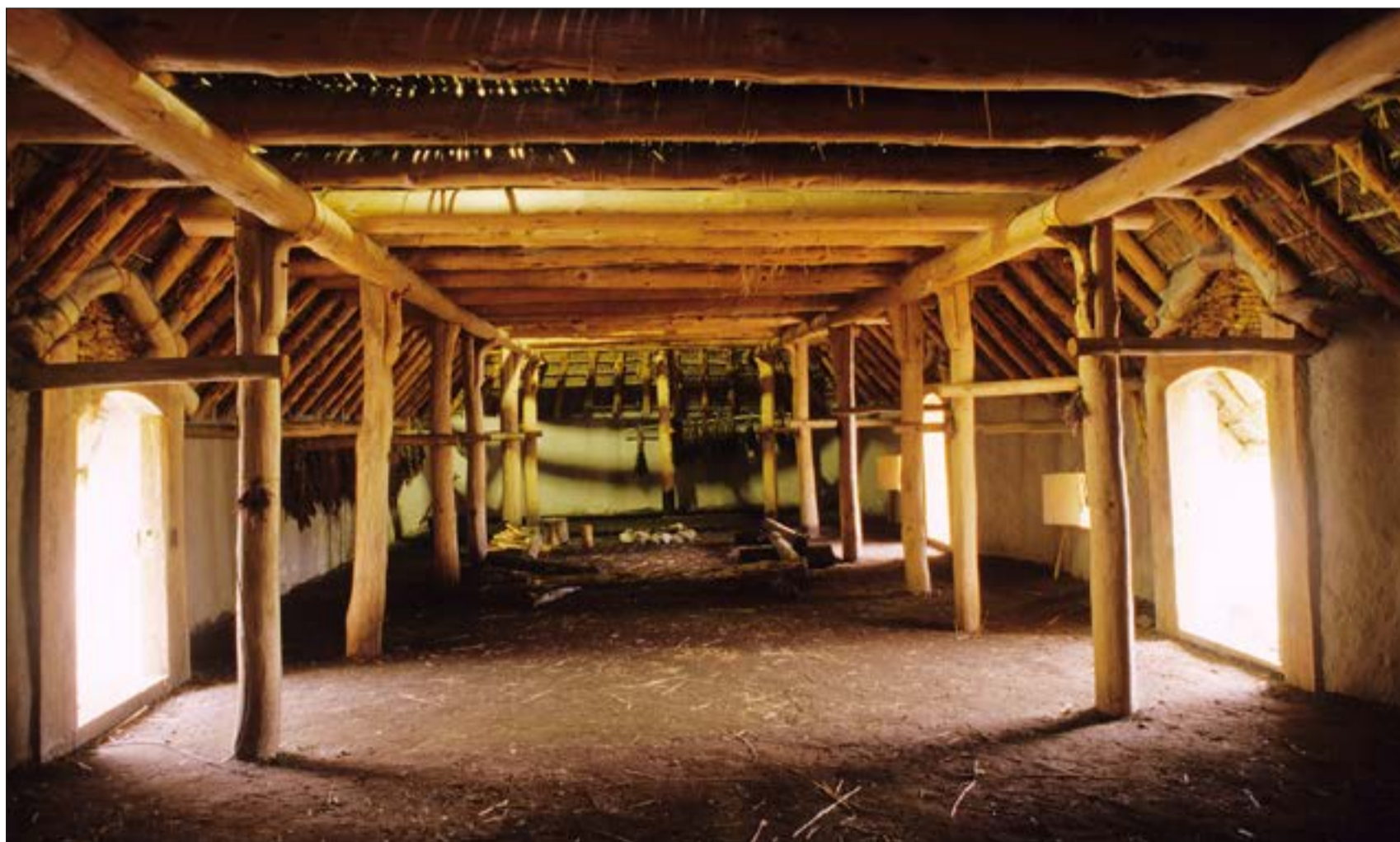
Gulv og gulvbelegg (side 62): Gulvet i bronsealderhuset er et stampet jordgolv, det vil si en blanding av leire og sand som er tråkket flatt. Foto: Åge Pedersen.
